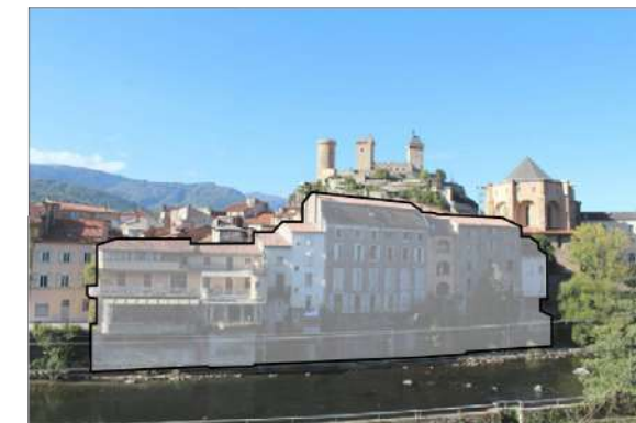
Conserver la volumétrie générale de l'îlot pour préserver la perception que l'on a de l'abbatiale et celle des toitures en secondes lignes.
